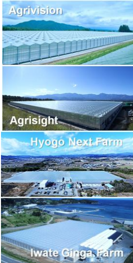
<太陽型植物工場>
