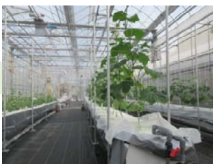
キュウリ実習用栽培施設にて 施設完成後最初の試験栽培
